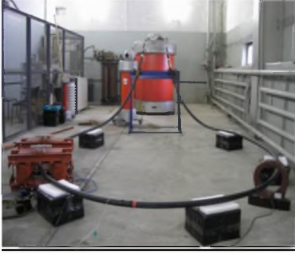
Рис.7 Кабельная сборка СНИК при измерении тангенса угла диэлектрических потерь.
