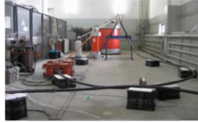
Рис.8 Кабельная сборка СНИК при измерении частичных разрядов и испытании циклами нагрева и охлаждения
